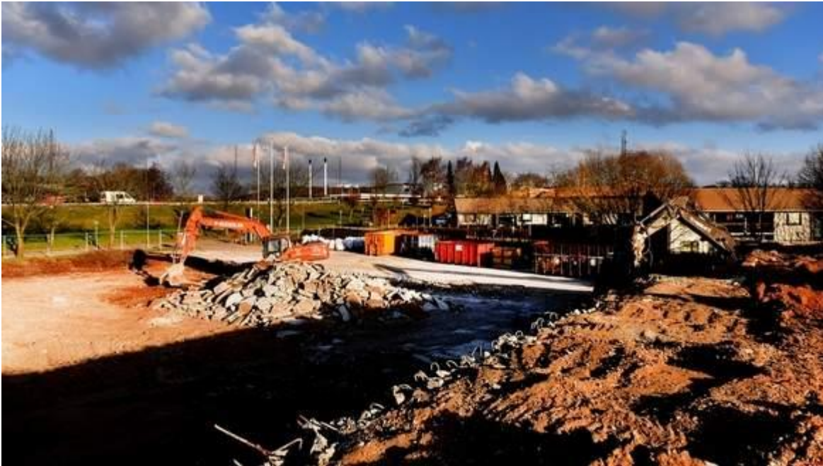
Base Erhverv er i fuld gang med nedrivningen af bygningen, der tidligere rummede Skousen, Jem&Fix og Babysam. Foto: Michael Svenningsen
