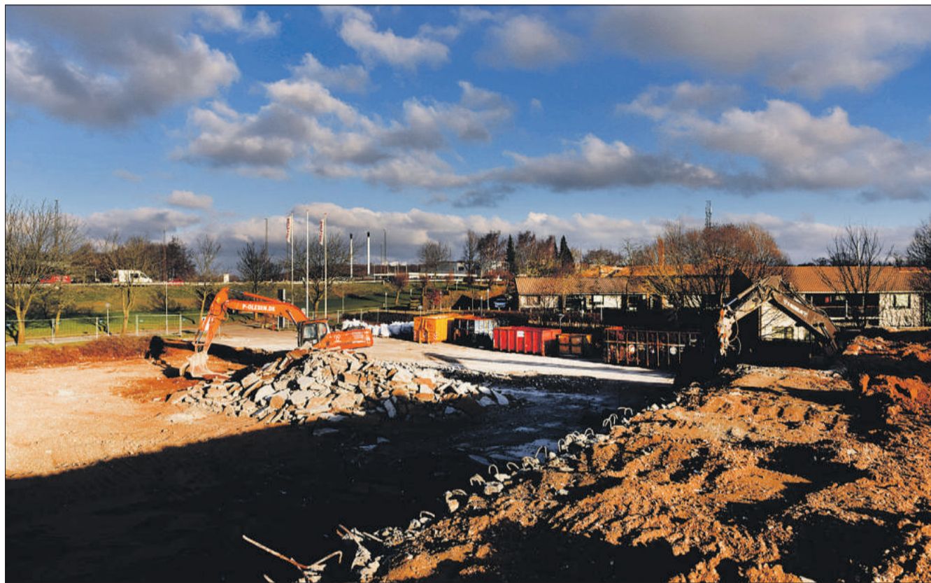
Base Erhverv er i fuld gang med nedrivningen af bygningen, der tidligere rummede Skousen, Jem&Fix og Babysam.
